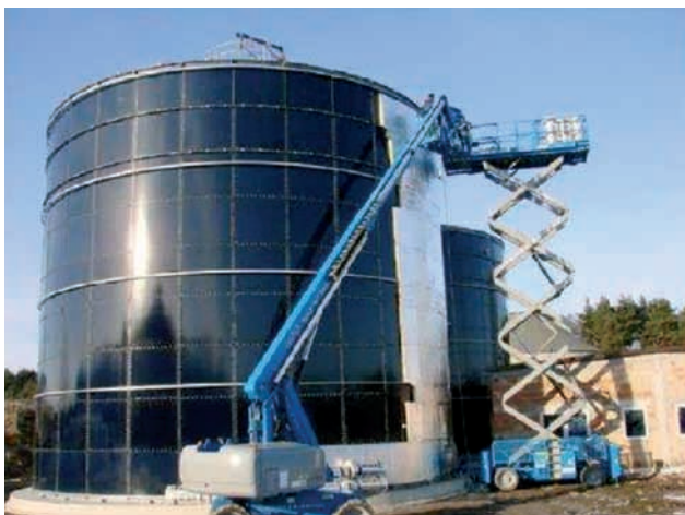
Рис. 4. Облицовка ферментера слоем стекловаты
